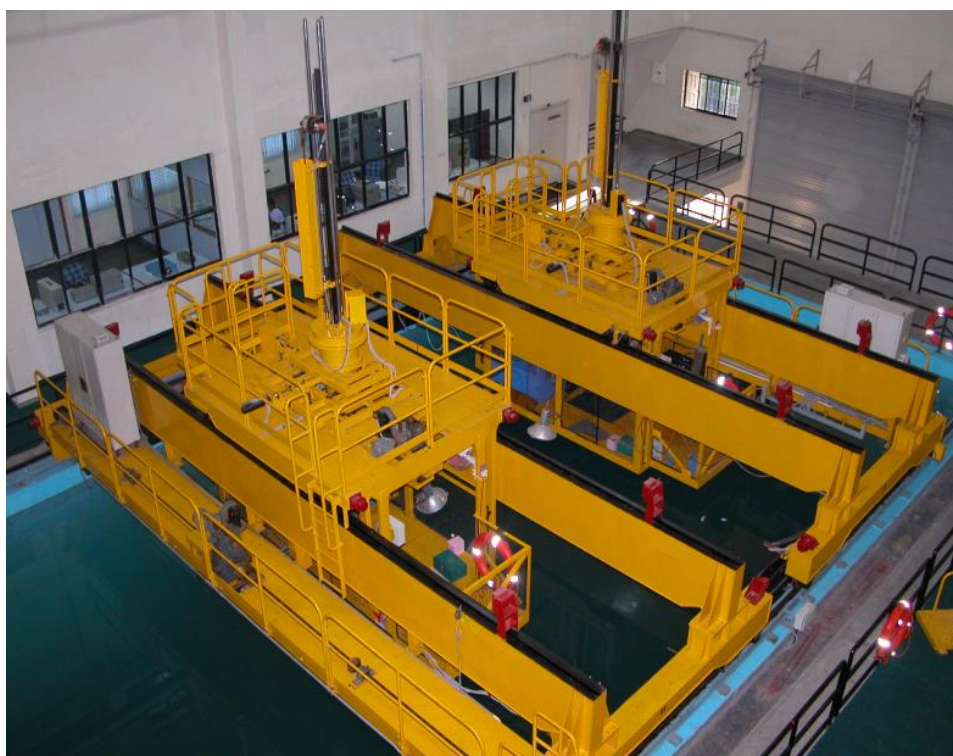
Figura 16. Instalaciones de hidroacústica del National Institute of Ocean Technology.
