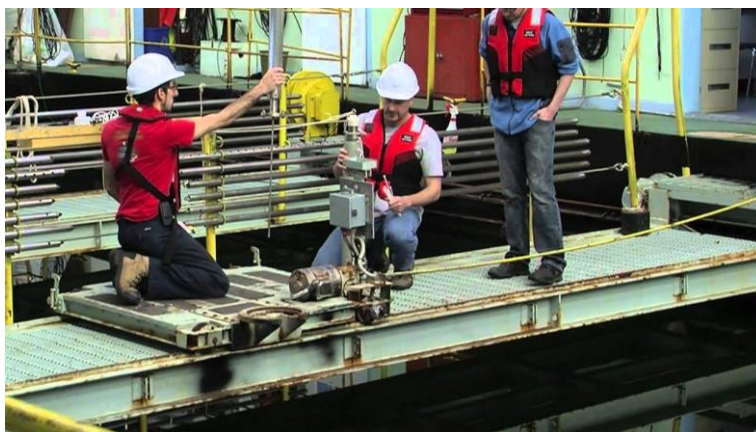
Figura 15. Instalaciones de hidroacústica de DRDC Atlantic Acoustic Calibration Barge (II).
